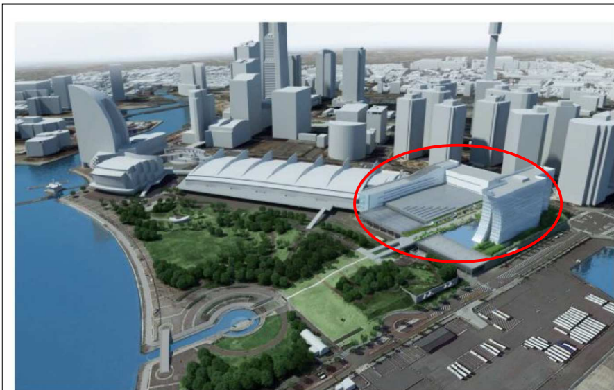
耐震ベース上空より20街区を望む
