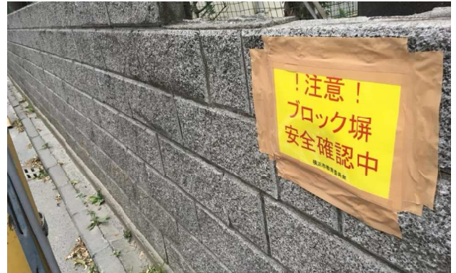
安全確認中のブロック塀＝7月4日鶴見区内
