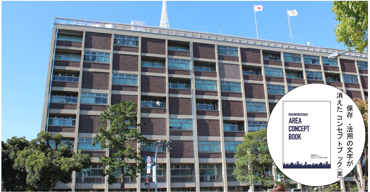
写真：現市庁舎
